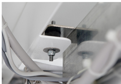
Schwingungsarme Aufhängung der Gebläse
